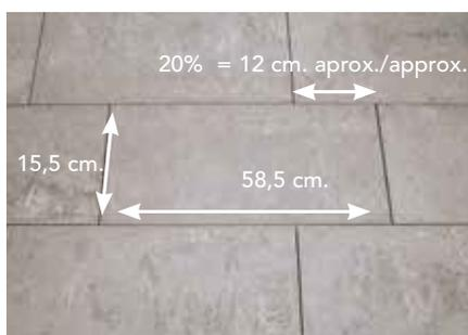
Tanto en pavimentos como en revestimientos, mantendremos la verticalidad y horizontalidad de las juntas, colocando las piezas perfectamente alineadas.
